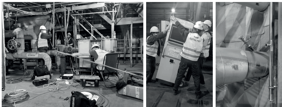
Rys. 8. Prace montażowe okablowania (po lewej) oraz głównej szafy sterowniczej (po środku) systemu dozowania modyfikatora spalania do kotła OP-430 w EC Siekierki, prowadzone w rygorach stanu pandemii, wspólnie przez pracowników KMB Catalyst, Kuncar S.A. oraz Instytutu Energetyki; układ wtrysku modyfikatora spalania do pyłoprzewodu wraz z kolektorem podczas montażu (po prawej).
